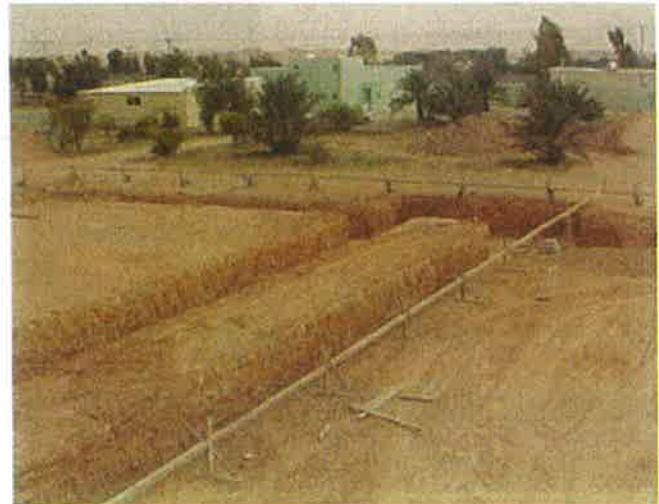
اكتمال أعمال الحفريات لوضع أساسات المباني
