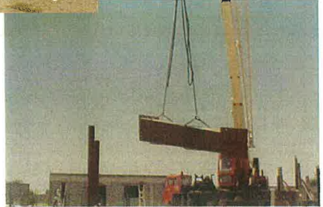
تركيب الأعمدة الحديدية مسبقة التصنيع
