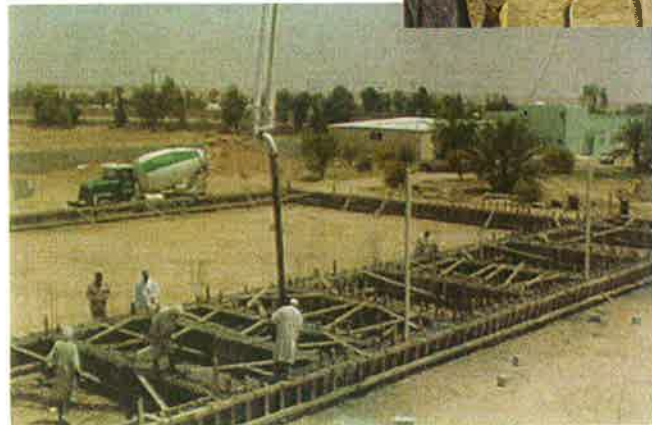
عملية صب الميدات لمباني الخدمات والمنافع الواقعة بين المجلس وصالة الطعام ويظهر بالخلف المبني القديم
