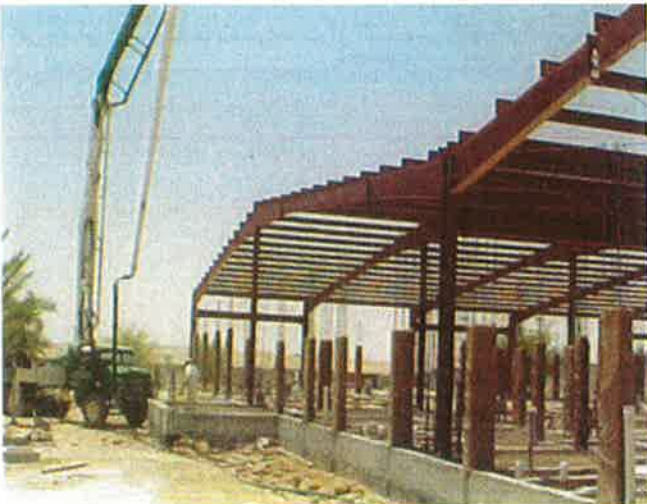
الإنشاءات الحديدية وقد شارفت على الاكتمال وكذلك يلاحظ اكتمال صب الأعمدة للمباني الخرسانية
