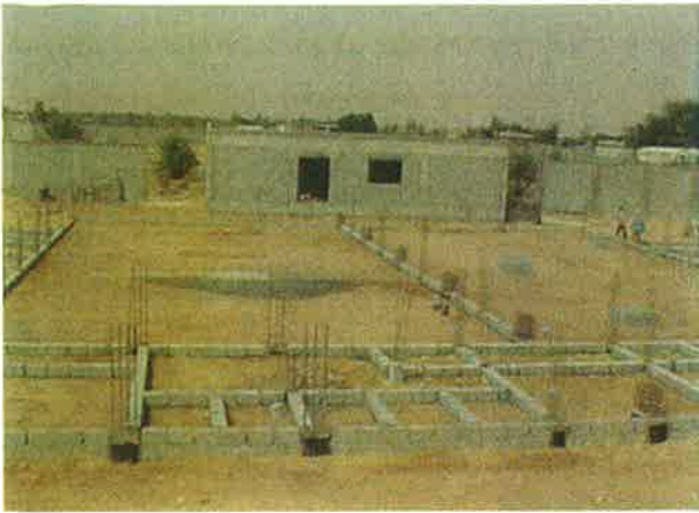
صالتي الطعام والمنافع بعد إكمال بناء أساسات صبة الميده ويظهر بالخلف المطبخ الرئيسي وغرفة تجهيز الطعام
